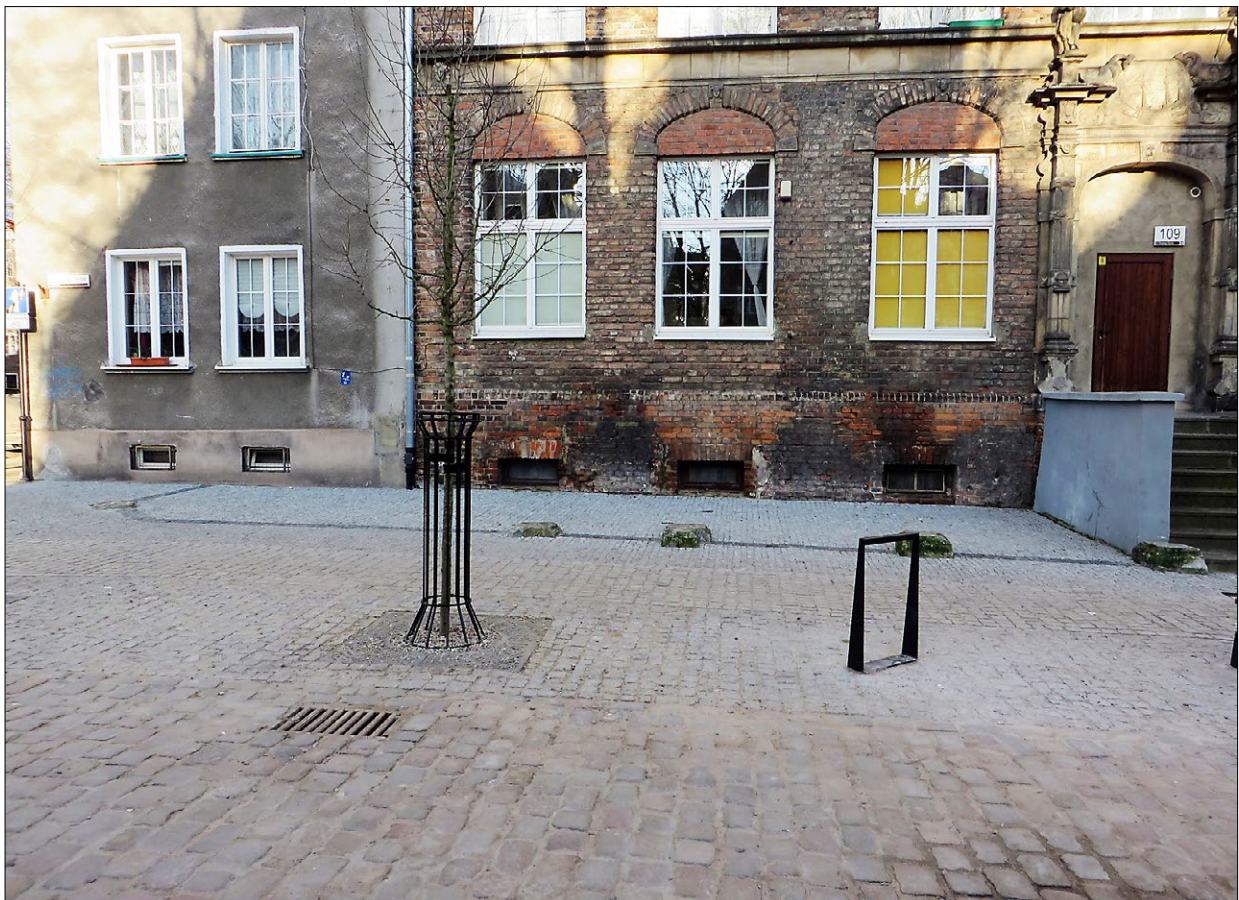
Ryc. 7. Gdańsk, ulica Świętego Ducha, stan po zakończeniu prac, rok 2017; fot. K. Szczepanowska.
