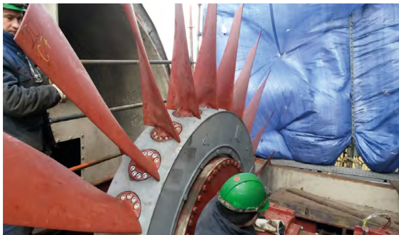
Fot. 8. Wymiana układu wirującego
