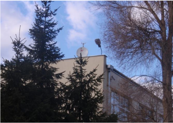
Rys. 3. Zewnętrzna część stanowiska laboratoryjnego (antena odbiorcza)
