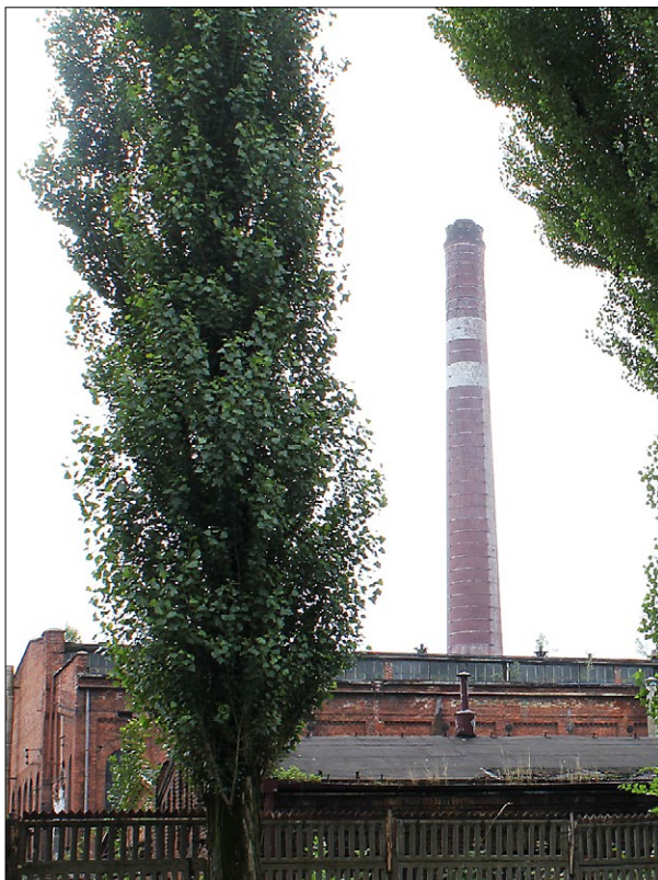
Ryc. 3. Komin elektrowni i fragmenty zabudowy fabrycznej widoczne zza ogrodzenia (powyżej) oraz elewacja jednego z zabytkowych obiektów (poniżej) planowana w ramach projektu Fuzja do adaptacji pod usługi i hotel, 2018; fot. M. Wdowiarz-Bilska.
