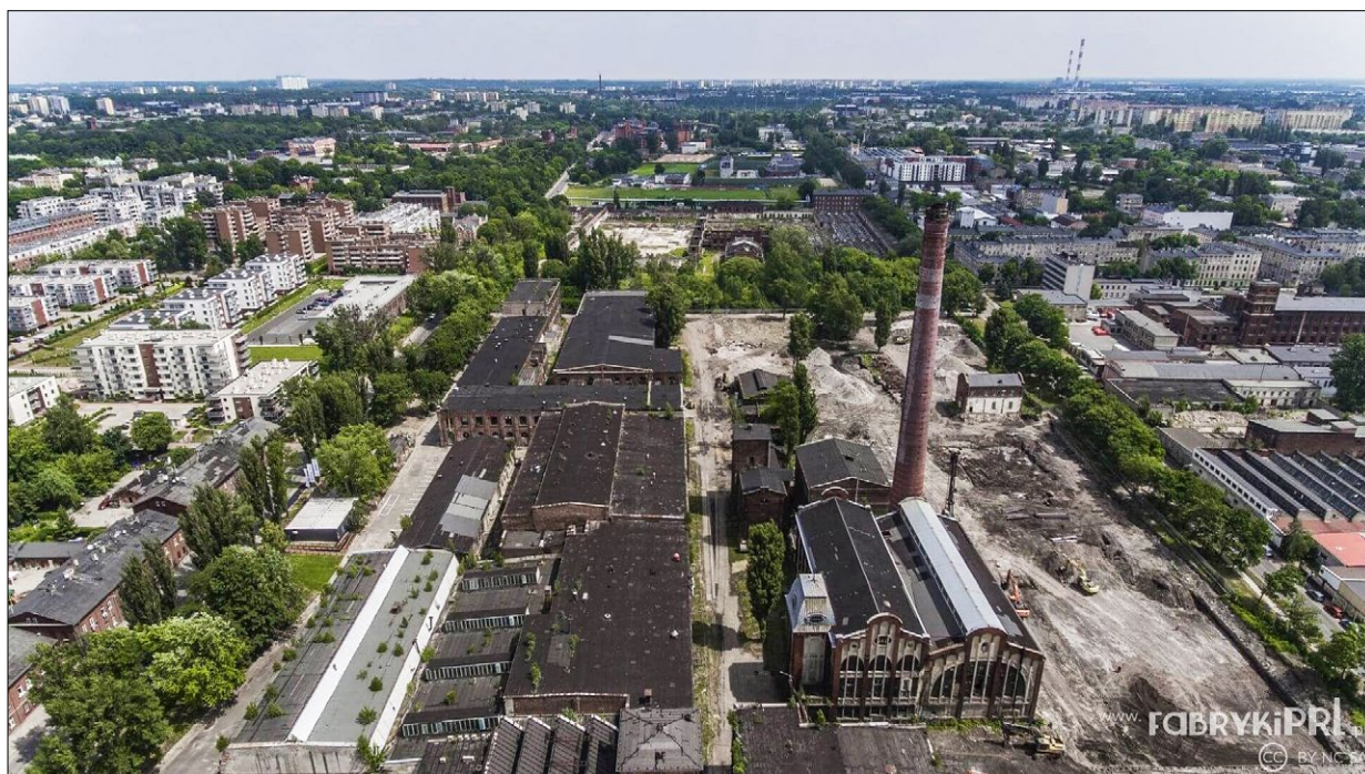
Ryc. 1. Kompleks Bielniki po oczyszczeniu terenu przed rewitalizacją, 2019; fot. K. Chodurek, fabrykipri.pl.
