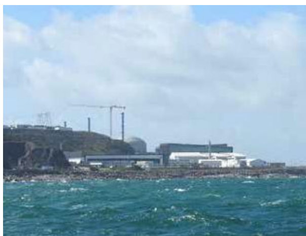
Fot. 1. Nowy blok nr 3 w EJ Flamanville, budowany w oparciu o mechanizm Exeltium (fot. jeanguyane, CC BY-NC-ND 2.0)
