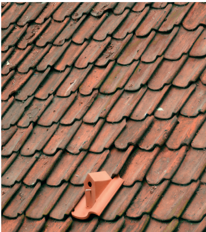
Ilustracja 2.: Dach kryty dachówką holenderką z wbudowanymi dachówkami lęgowymi, autorstwa Klaasa Kuikena. Źródło: Klaas Kuiken.
