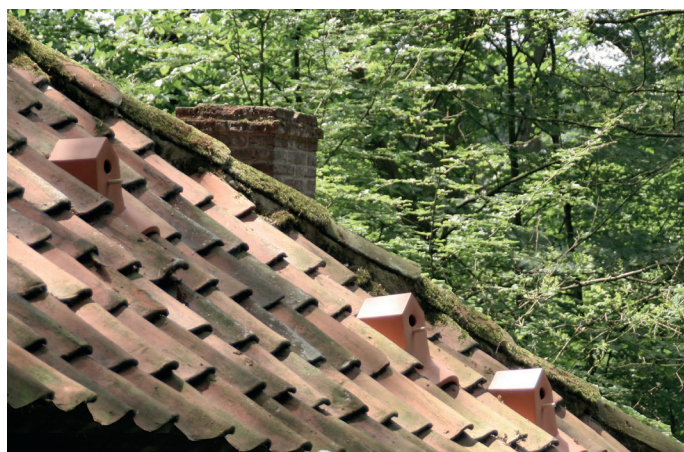
Ilustracja 1: Dach kryty dachówką holenderką z wbudowanymi dachówkami autorstwa Klaasa Kuikena. Źródło: Klaas Kuiken.
