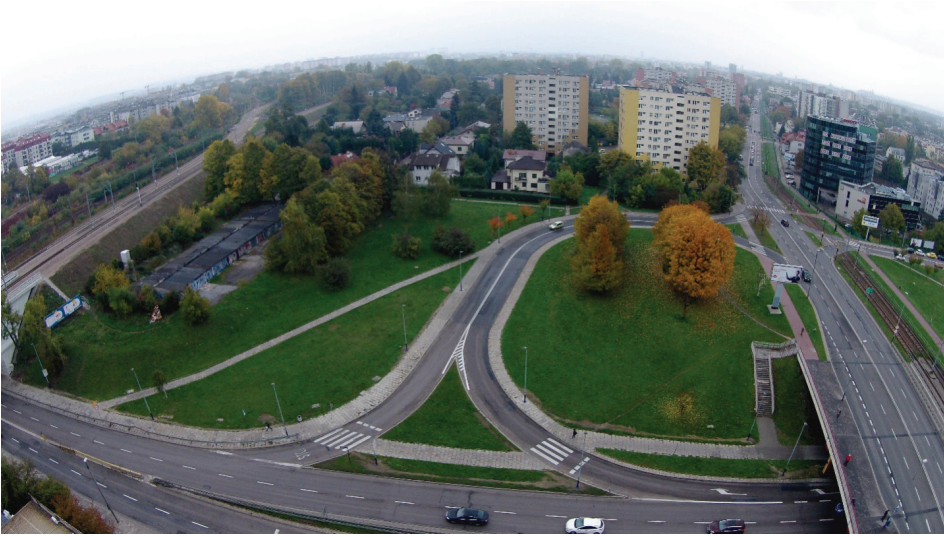
Rys. 2. Węzeł drogowy „Bronowice”.
