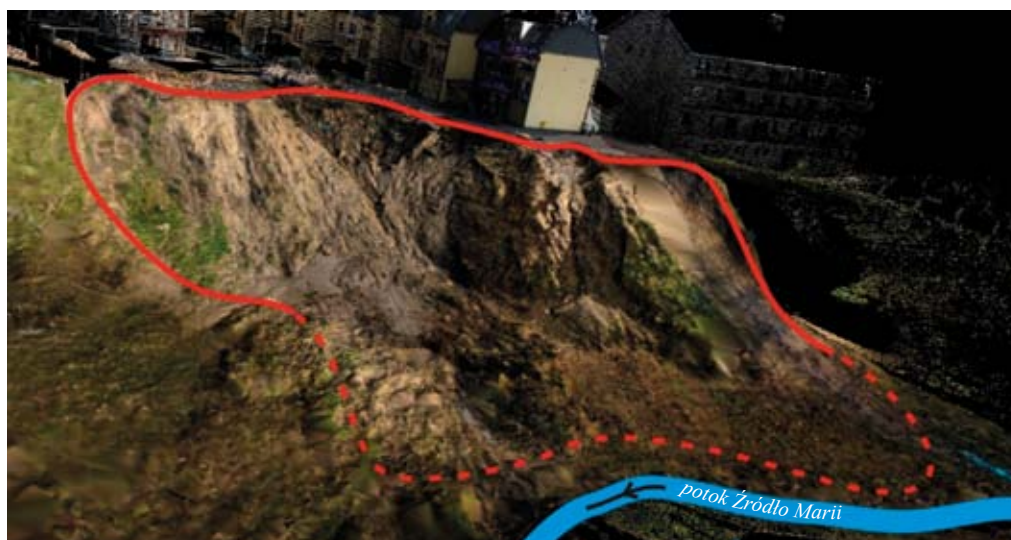
Fig. 12. Zasięg osuwiska przy ul. Ornej (kwiecień 2011 r.) na podstawie TLS, widok perspektywiczny w kolorystyce fotorealistycznej
