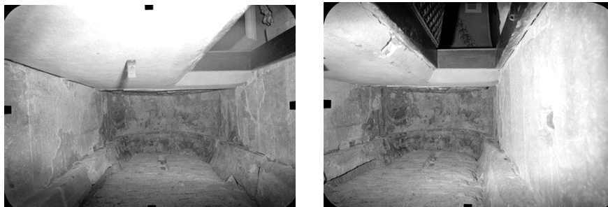
Rys. 2. Stereogram z kamery UMK 10/1318 - widok na sklepienie nawy i absydioli
