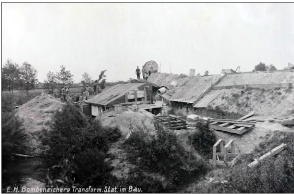
Ryc. 3. Stacja transformatorowa „Mogiła” podczas budowy – realizacja prac betonarskich; widoczna bryła schronu przed zasypaniem ochronną warstwą ziemi; na koronie wału przeciwpowodziowego poprowadzono tor kolejki polowej zaopatrującej plac budowy; fot. archiwalna z 1915, odbitka w zbiorach autora.
