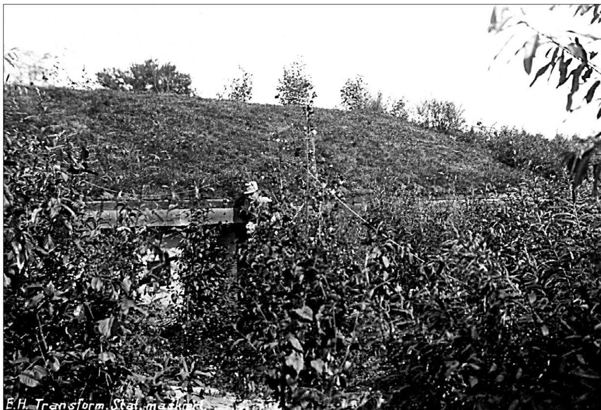
Ryc. 5. Stacja transformatorowa „Mogila” – schron ukończony i zabezpieczony maskowaniem, widok od strony zapola; stropodach obłożono darnią, a wokół ścian schronu wykonano nasadzenia maskujące z krzewów i ciętych młodych drzewek; widoczna wnęka otworu wejściowego; fot. archiwalna z 1915, odbitka w zbiorach autora.
