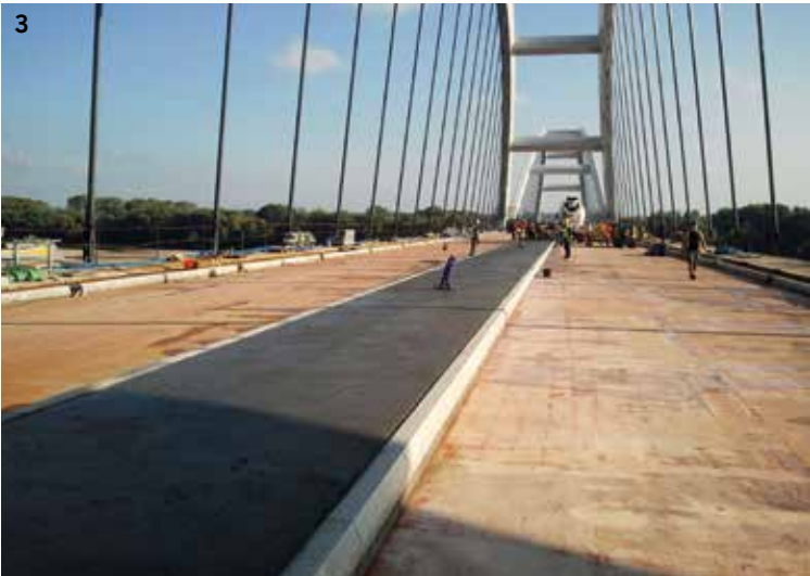
Fot. 2. Formowanie kap chodnikowych jako ciąg zabiegów: rozładunek, zagęszczenie, wyrównanie i zacieranie powierzchni mieszanki betonu lekkiego Fot. 3. Wykonana kapa chodnikowa z betonu lekkiego
