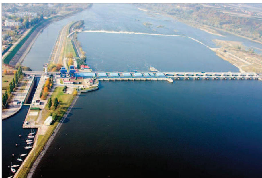
Fot. 10. Elektrownia wodna we Włocławku
