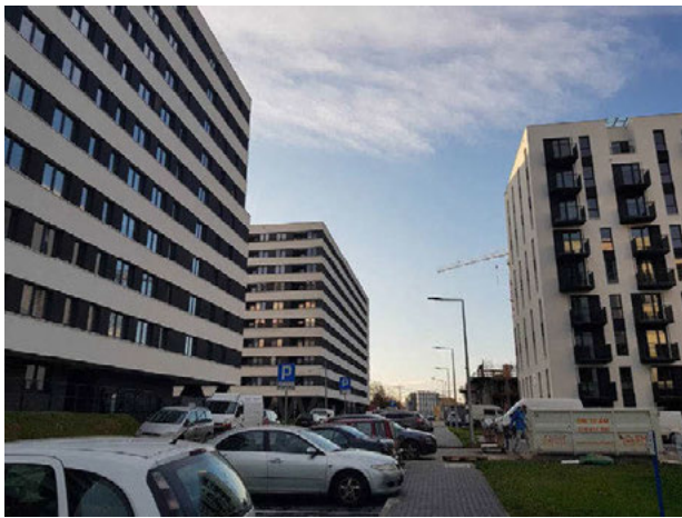
Il. 9. Intensywna zabudowa wielorodzinna po północnej stronie krakowskiego osiedla Piastów (fot. E. Szczerek).
