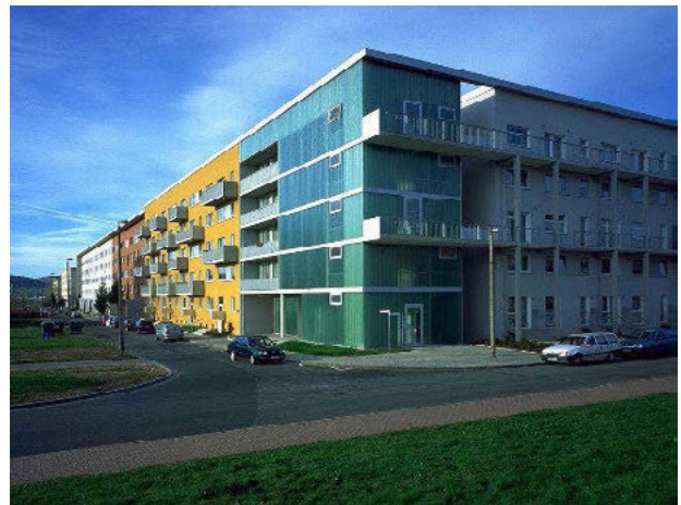
II. 15. Uzupełnienie narożnika między zmodernizowanymi obiektami wielopłytowymi.
