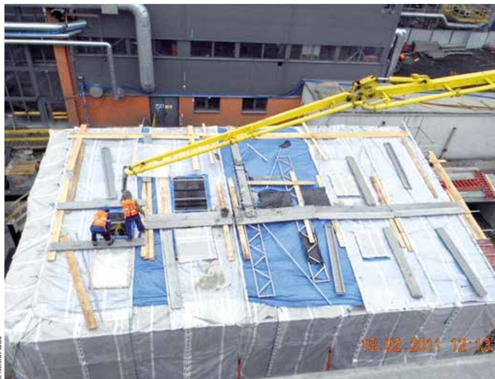
Wykonywanie robót betonowych zimą z zastosowaniem ciepłaka
