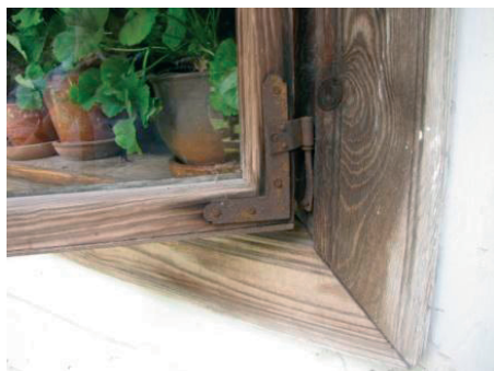
Fot. 7. Stolarka okienna- zawias z hakiem. Chałupa z Żabna (1895 r.)
