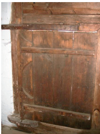
Fot. 15. Drzwi sponowe na biegunach. Chałupa z Bukowej (1857 r.)
