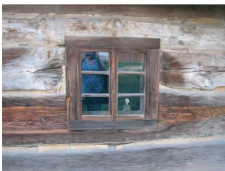
Fot. 3. Okno sześcioszybowe nieotwierane. Chałupa z Tarnogóry (1773 r.)
