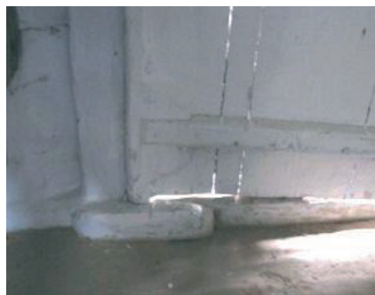
Fot. 20. Biegun dolny w drzwiach sponowych. Chałupa z Żukowa (pocz. XIX w.)
