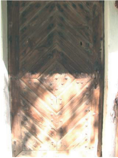
Fot. 23. Drzwi sponowe „szalowane” (od zewnątrz). Chałupa z Niemiec(1896 r.)
