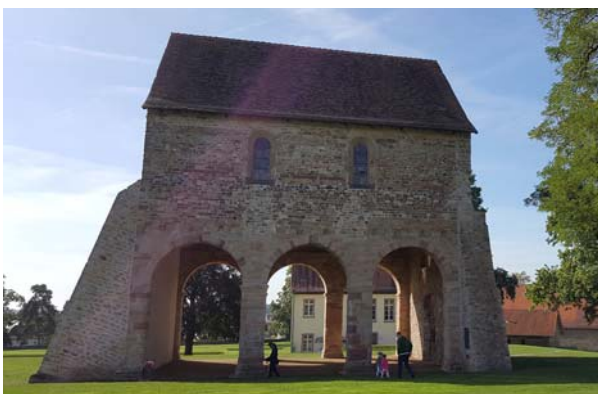
Ryc. 11. Widok na zachowany fragment kościoła św. Nazariusza od strony północnej. Fot. autorzy, 2016
