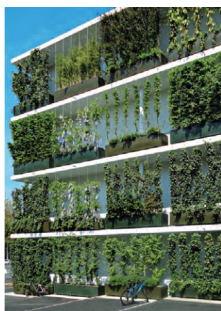
Rys. 8. Elewacja z roślin pnących na linach ze stali nierdzewnej [8]
