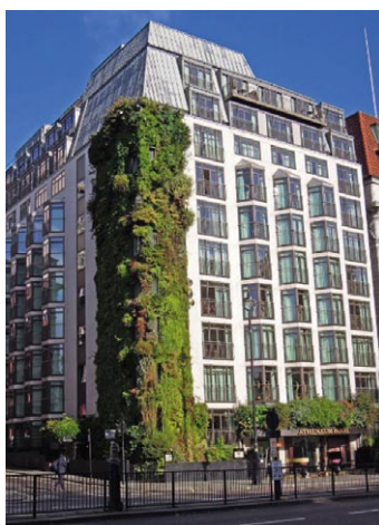
Rys. 2. Narożnik budynku zaakcentowany zielenią [2]
