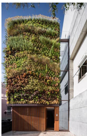
Rys. 1. Zielona elewacja w systemie żyjącej ściany [1]
