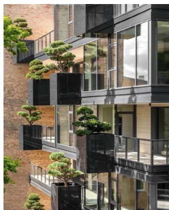
Rys. 14. Apartamentowiec w Rydze, projekt biura OPEN AD [14]
