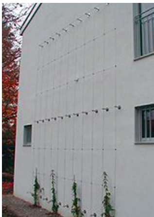
Rys. 6. Pnącza na linach ze stali nierdzewnej [6]
