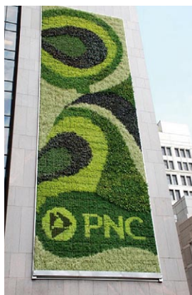
Rys. 4. Elewacja banku w Pittsburghu [4]
