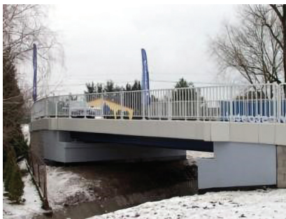
Rys. 34. Most w miejscowości Nowa Wieś, konstrukcja całkowicie kompozytowa, l = 10,00 m, 2016 rok [3]
