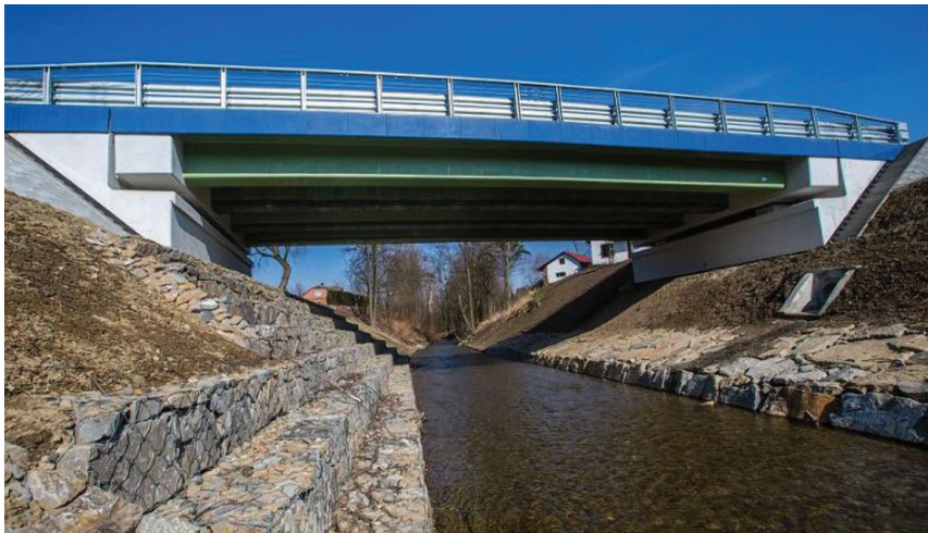
Rys. 33. Most w miejscowości Błażowa, konstrukcja hybrydowa – kompozytowe dźwigary główne i zespolona z nimi płyta pomostu z betonu lekkiego zbrojonego prętami GFRP, l = 20,00 m, 2015 rok [3]
