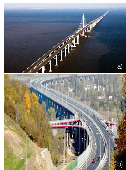
Rys. 26. Rekordowe przeprawy i trasy mostowe: a) na świecie – Qingdao Hawan, Chiny, 42,58 km, 2011 rok; b) w Polsce – estakada WE1 w ciągu Południowej Obwodnicy Gdańska, 2,75 km, 2012 rok [3]
