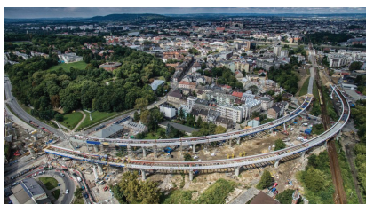
Rys. 28. Budowa estakad kolejowych w Krakowie [3]
