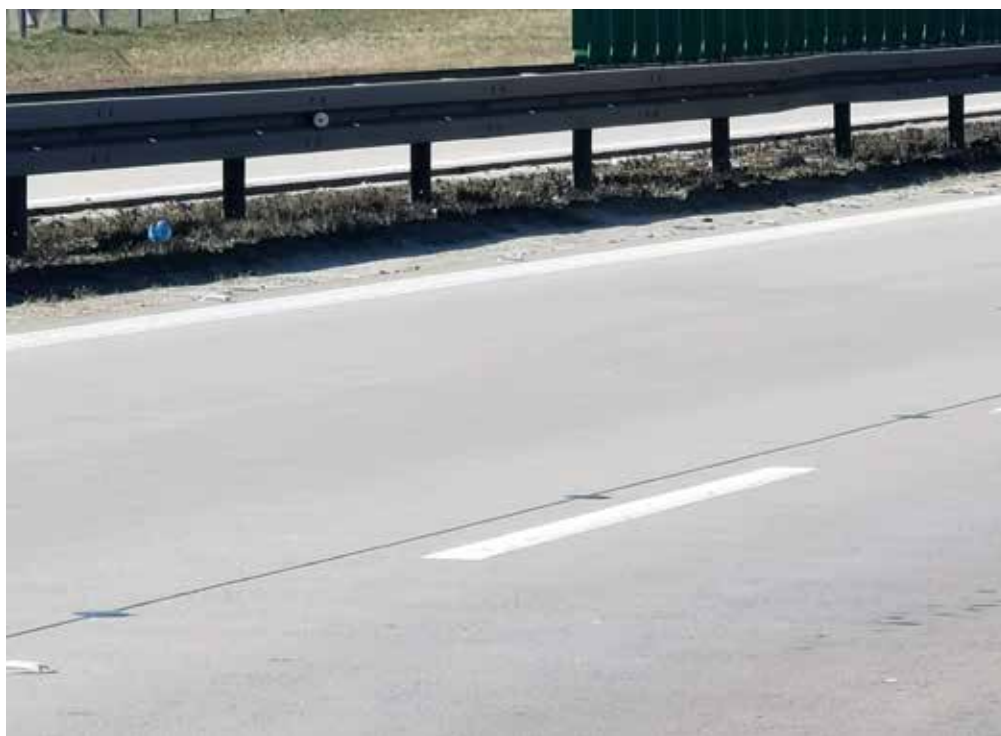
Fot. 2. Widok stanu nawierzchni oraz stanu szczeliny podłużnej – brak uszkodzeń. Źródło: [8]
