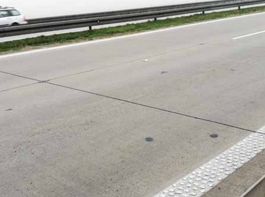
Fot. 3. Widok stanu nawierzchni oraz stanu szczeliny podłużnej i poprzecznej – brak uszkodzeń. Źródło: [8]
