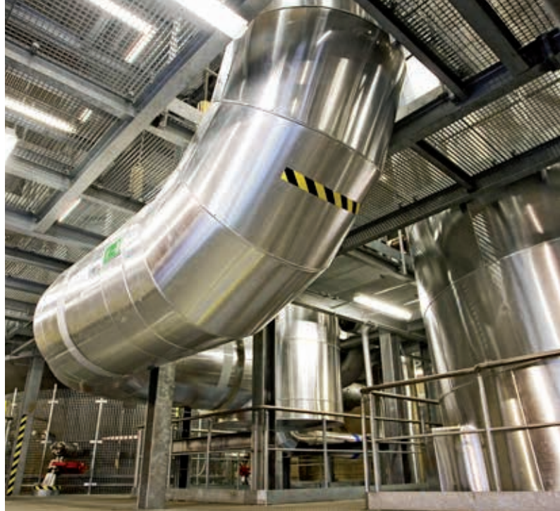
Fragment głównego kanału spalin pomiędzy wymiennikami, tj. rekuperatorem a ekonomizere
