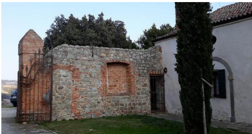
Ryc. 7 Detal północnej ściany zespołu zabytkowego, która została zidentyfikowana jako północna ściana starożytnego średniowiecznego kościoła klasztornego. W murze widoczna jest nisza i zamurowane drzwi
