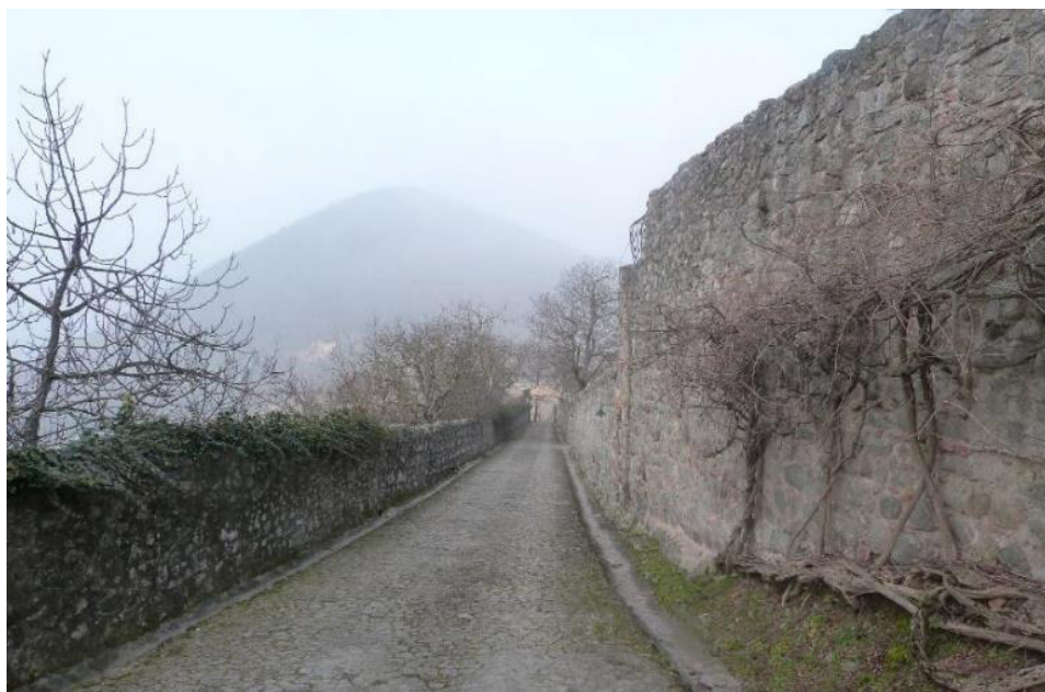
Ryc. 3 Widok z góry na rampę dojazdową, ukazujący średniowieczne mury i portal na dole
