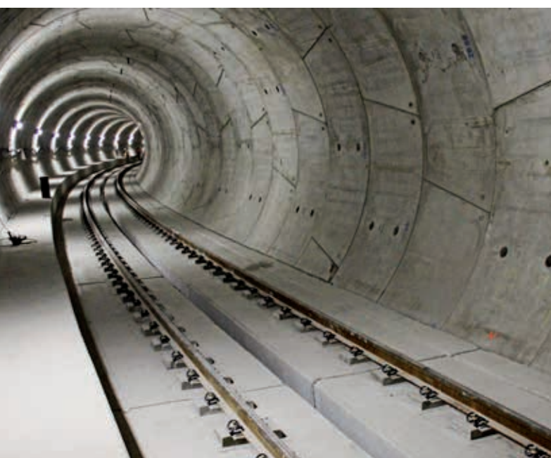
Torowisko w łączniku Z1
