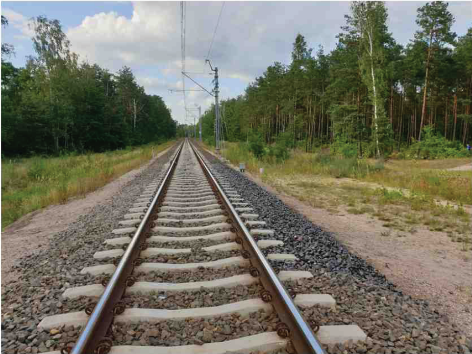
Fot. 5. Dzikie przejście w km 13,800 toru nr 2 linii nr 449 jeden dzień po zakończeniu aplikacji żywicy
