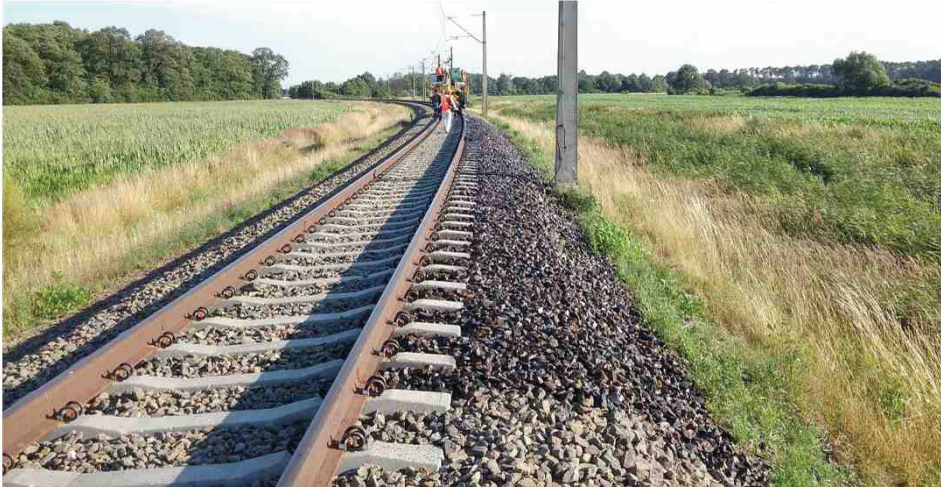
Fot. 3. Aplikacja żywicy na torze doświadczalnym w Żmigrodzie
