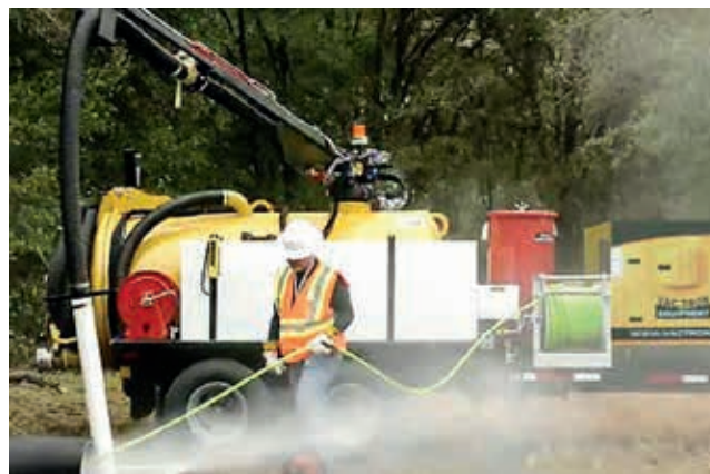
Ryc. 10. Urządzenie Vac-Tron do próżniowego wykonywania wykopów
