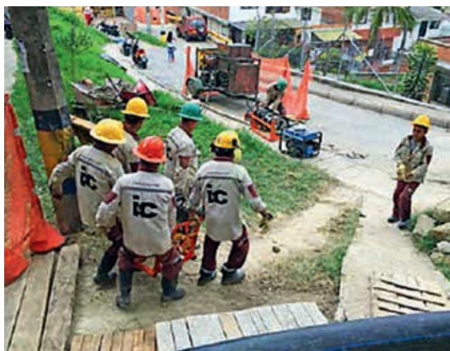
Ryc. 3. Ręczne dostarczanie wyposażenia na teren budowy
