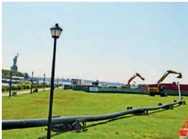
Ryc. 7. Widok przewodu wodociągowego przygotowanego do realizacji na wyspie Liberty Island
