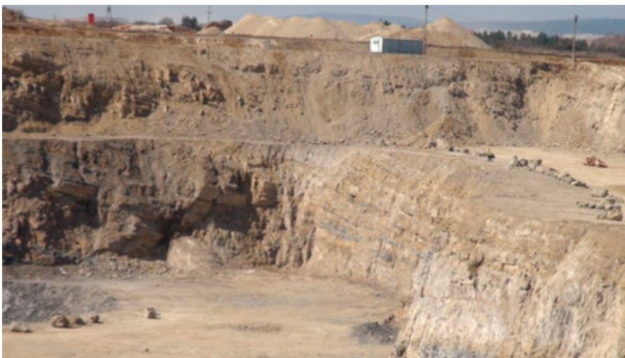
Ściana przygotowana do odstrzału
