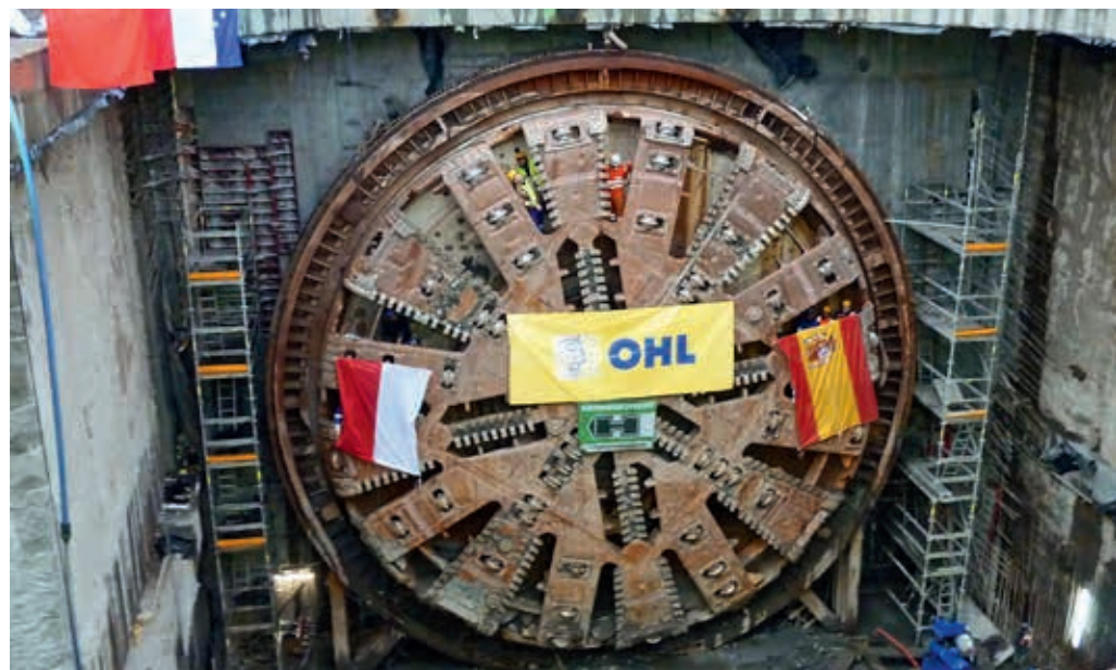
Ryc. 2. Widok szybu docelowego i czoła (noża) maszyny drążącej, fot. D. Ganew
