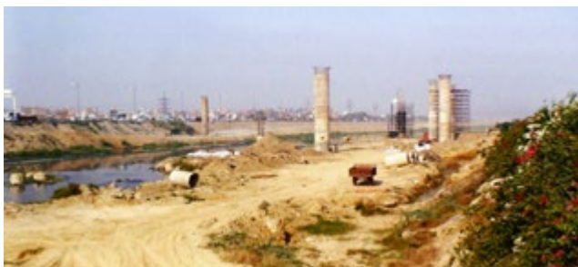
Ryc. 11. Trudne warunki terenowe podczas budowy kolektora w Delhi [6, s. 39]
