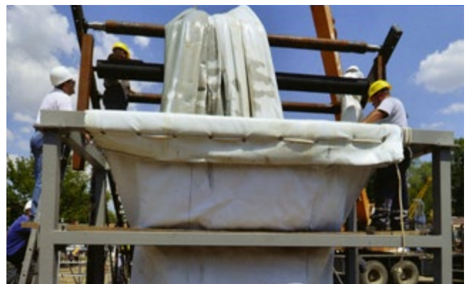
Ryc. 2. Inwersja linera w szybie startowym na terenie elektrowni w Kazachstanie [6 s. tytułowa]
