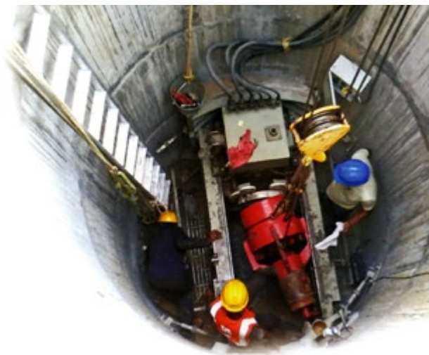
Ryc. 12. Montaż urządzeń w studni startowej na placu budowy w Delhi [6, s. 40]
