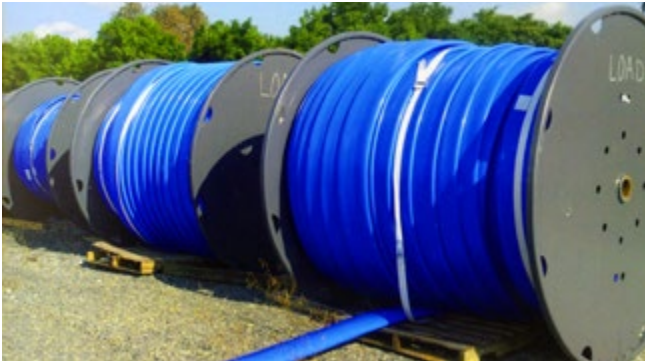
Ryc. 5. Rękaw Primus Line przygotowany do instalacji na placu budowy w bazie wojskowej w Mechanicsburgu [6, s. 50]
