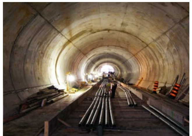
Ryc. 8. Tunel Billy Bishop podczas prac budowlanych [2]
