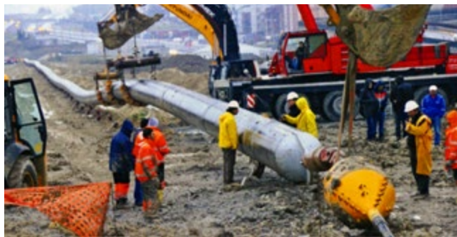
Ryc. 3. Rurociąg przygotowany do wciągania na placu budowy w Istanbule [6, s. 21]
