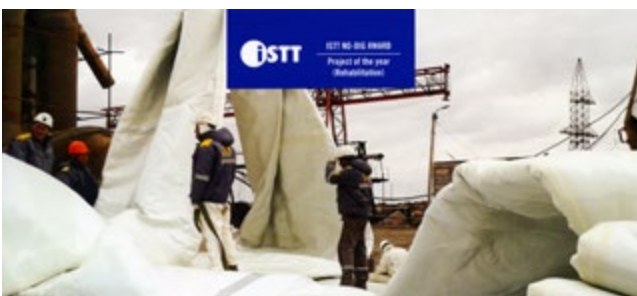
Ryc. 1. AquaCure RP liner na placu budowy w elektrowni w Kazachstanie [6, s. 16]
