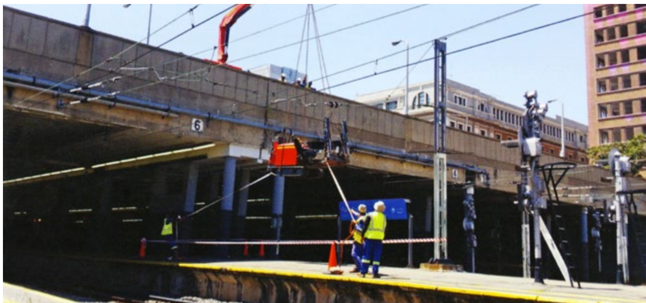
Ryc. 10. Ustawianie wiertnic na peronie stacji kolejowej w Johannesburgu [6, s. 32]
