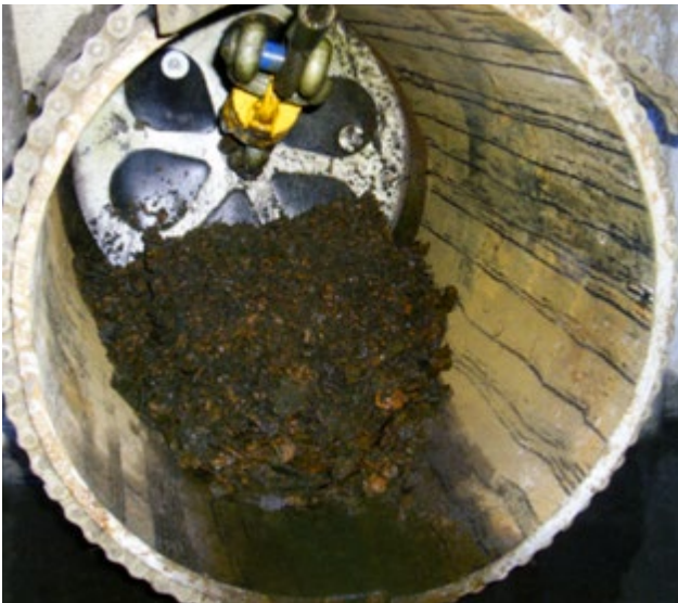
Ryc. 6. Czyszczenie przewodów wodociągowych przed przystąpieniem do renowacji [6, s. 51]
