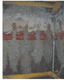
Kolumny iniekcyjne wykonane w układzie kozłowym
