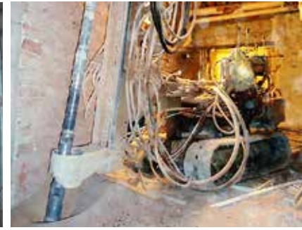
Widok wiertnicy podczas prac wiertniczo-iniekcyjnych
