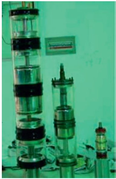
Fot. 1. Porównanie komór próżniowych stosowanych w wyłącznikach NN, WN i SN (od lewej strony) 245, 126 i 12 kV [6]
