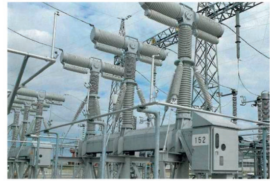
Konstrukcja: live tank Napięcie znamionowe: 168 kV Prąd znamionowy: 2 000 A Prąd zwarciaowy: 31,5 kA Izolacja dodatkowa: SF 6 Liczba komór próżniowych: 2/fazę Mechanizm: sprężynowo-zasobnikowy
