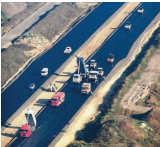
Rys. 1. Układanie podbudowy zasadniczej na odcinku A
