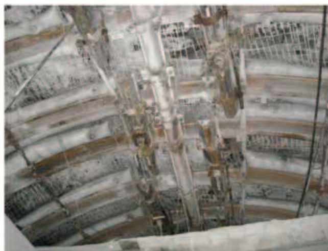
Rys. 7. Widok przykotwionych łuków stropowych oraz wykładki mechanicznej
