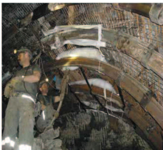
Rys. 6. Brygada przodkowa podczas zatłaczania spoiwa do pojemników wykładki mechanicznej
