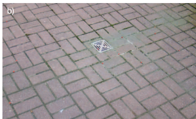
Rys. 4. Patio wewnętrzne: a) widok warstwy wykończeniowej w postaci okładziny z kostki betonowej z pokazaniem zabudowy roślinnością ozdobną, b) szczegół wpustu podłogowego w zbliżeniu
