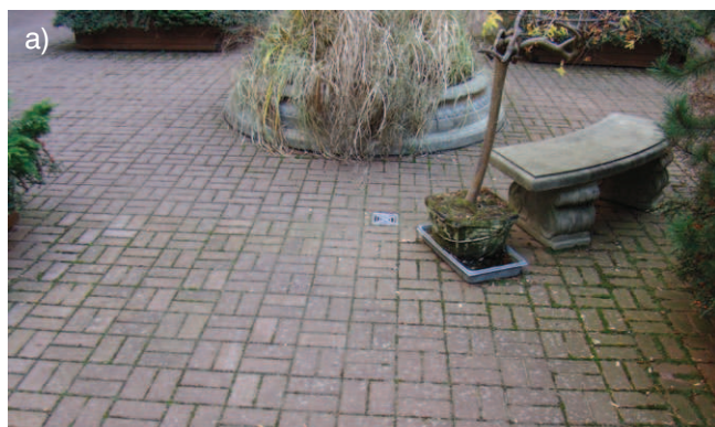
Rys. 4. Patio wewnętrzne: a) widok warstwy wykończeniowej w postaci okładziny z kostki betonowej z pokazaniem zabudowy roślinnością ozdobną, b) szczegół wpustu podłogowego w zbliżeniu
