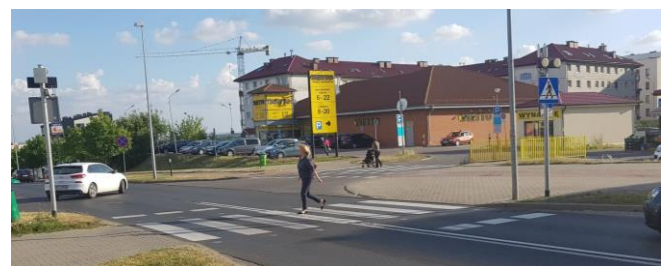
Rys. 5. Przejście dla pieszych z sygnalizacją ostrzegawczą
