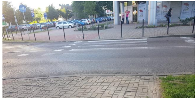
Rys. 3. Zły stan techniczny oznakowania poziomego Źródło: Opracowane własne
