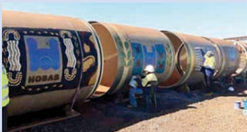
Ryc. 10. Rury firmy Hobas o niskiej emisji dwutlenku węgla, które zostały zastosowane w zachodniej Australii [1]
