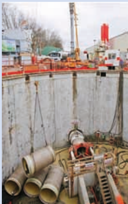
Ryc. 2. Plac budowy kolektora odciążającego Sekwanę z widoczną komorą startową [1]
