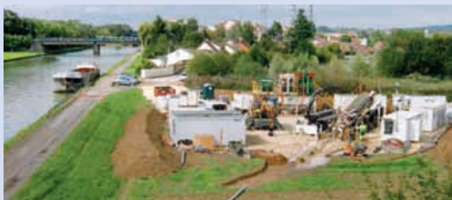
Ryc. 5. Widok na plac budowy z widoczną wiertnicą HK 100
