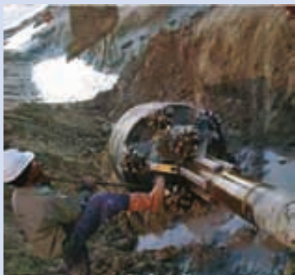
Ryc. 9 Jednoetapowy dwustopniowy poszerzacz firmy Transco MFG Australia Pty. Ltd [1]
