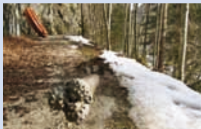
Ryc. 7. Wiertło w punkcie wyjścia pod koniec pierwszego etapu przewiertu [1]
