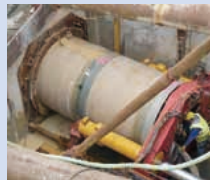
Ryc. 4. Widok komory startowej [1]
