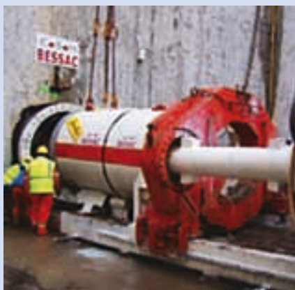
Ryc. 1. Maszyna do mikrotunelowania podczas wykonywania prac [1]
