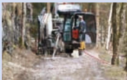
Ryc. 6. Wiertnica Grundodrill 18ACS podczas wiercenia pilotowego ustawiona na wąskiej drodze pomiędzy pionowymi ścianami skalnymi [1]
