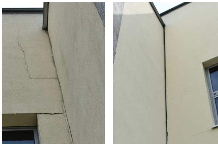
Rys. 4. Strefa dylatacji łącznika (po lewej od strony wschodniej, po prawej od strony zachodniej)
