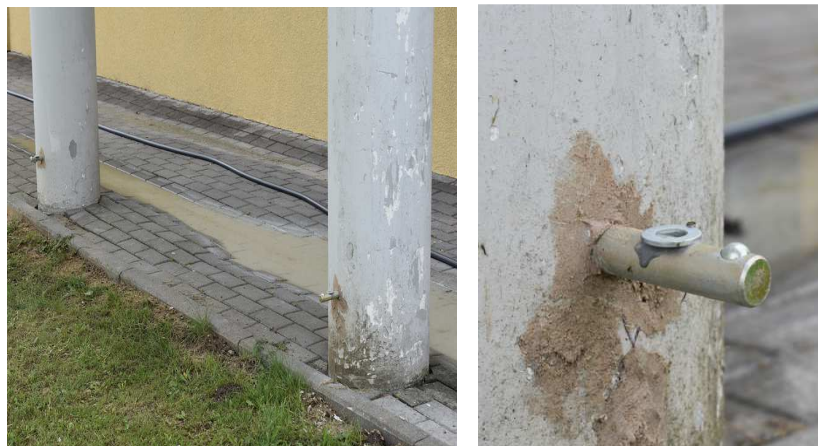
Rys. 5. Repery posadowienie na badanych słupach (po lewej) oraz stabilizacja repera nr 10 (po prawej)
