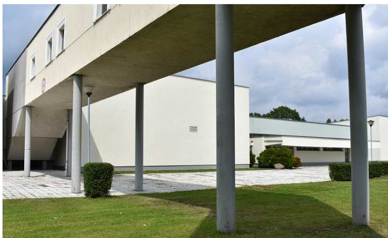
Rys. 2. Widok ogólny łącznika od strony Auditorium Novum
