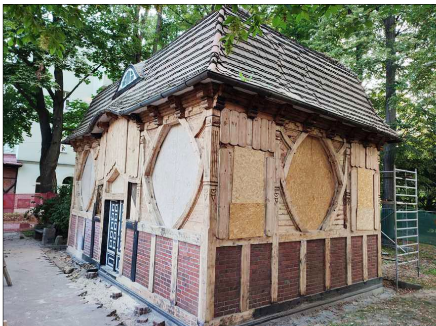
Ryc. 6. Budynek podczas prac, 2022; fot. Konior Przedsiębiorstwo Budowlane Fig. 6. The building whilst work in progress, 2022; photo by Konior Construction Company
