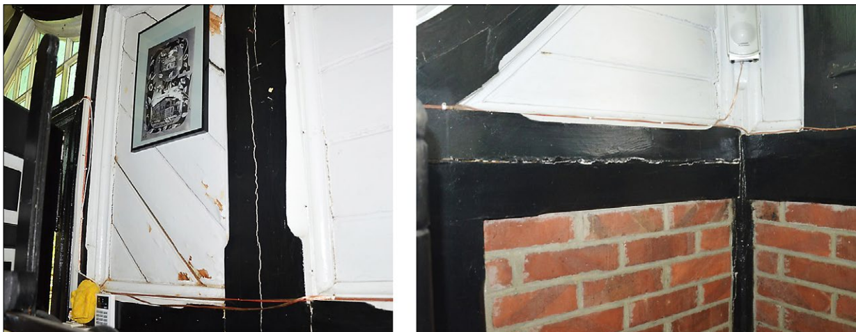
Ryc. 5. Pomiar zawilgocenia muru ceglanego od zewnątrz, odczyt 4,9 proc., 2019; fot. Stekra
