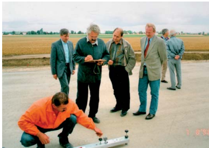
Fot 10. Pomiar i analiza wyników pomiarów ugięć sprężystych podbudowy pomocniczej z mieszanki mce; stoją: (od lewej strony) Stanisław Barszczak, Stanisław Gubernat, Antoni Szydło i Eugeniusz Mróz; za E. Mrozem stoi Tadeusz Mańkowski (fot. Konrad Jabłoński 08.07.1998 r.)
