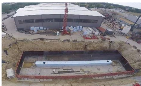
Rys. 5. Szalunek płyty dennej (źródło: IN-BUL; autor: Paweł Bulczak)
