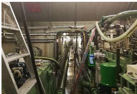
Rys. 4. Tunel technologiczny (źródło: materiały własne)
