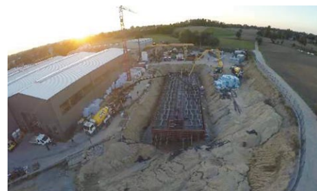
Rys. 6. Betonowanie płyty dennej (źródło: IN-BUL, autor: Paweł Bulczak)
