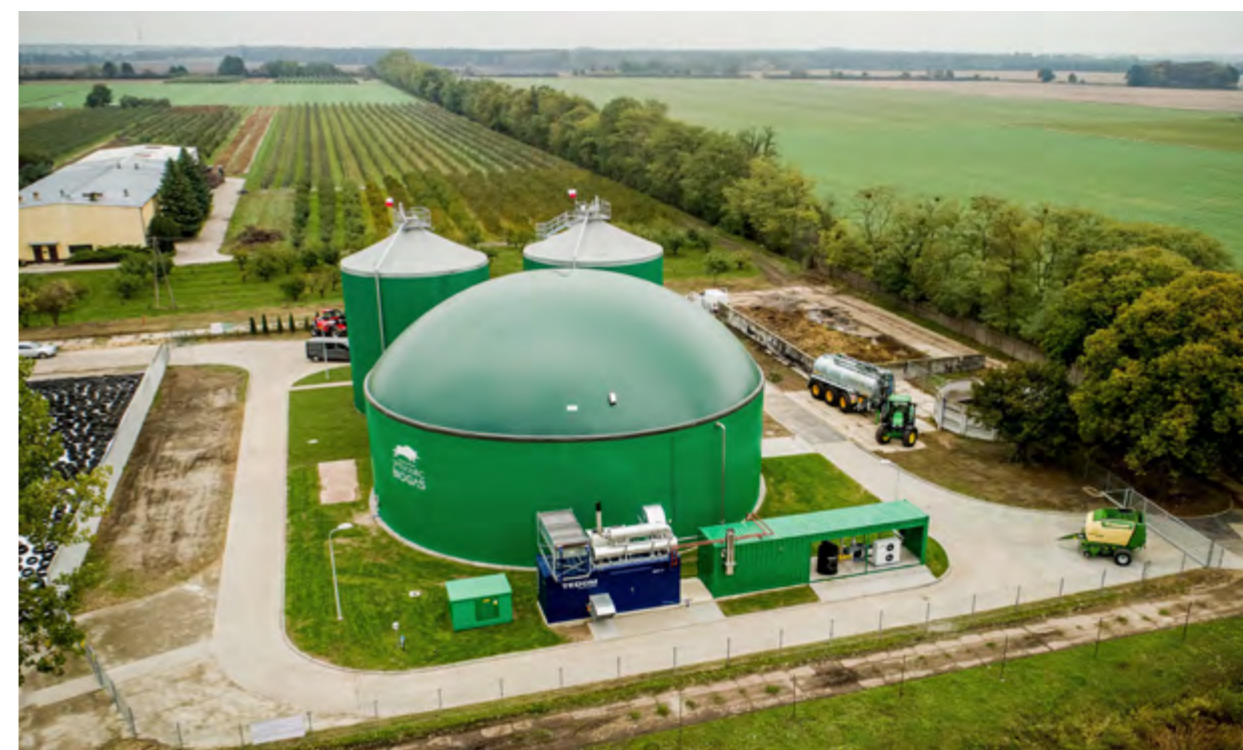
Biogazownia w Przybrodzie 0,5 MW przystosowana do pracy jako instalacja szczytowa 0,8 MW
