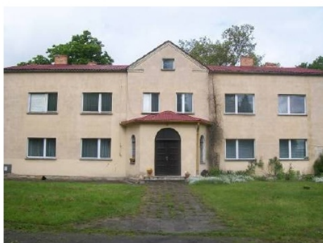
Ryc. 10. Dwór – elewacja frontowa (fot. P. Urbański, 2016)
