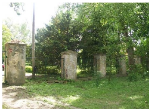
Ryc. 6. Ogrodzenie od strony wschodniej (fot. P. Urbański, 2016)
