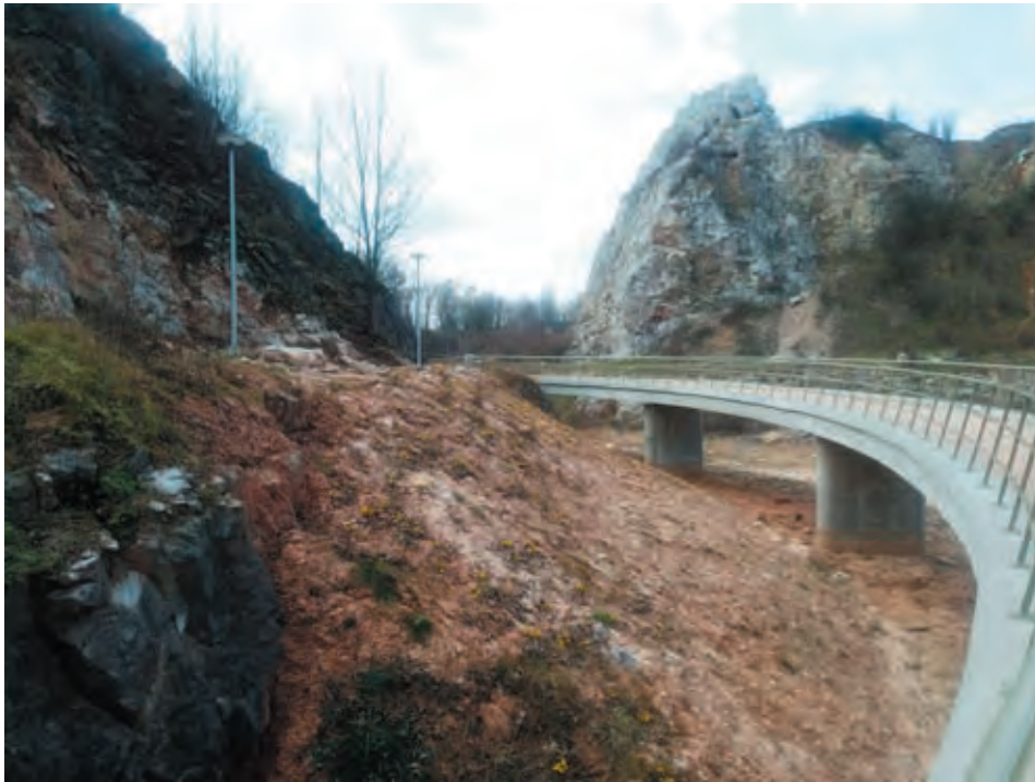
Fot. 4. Ścieżka piesza na estakadzie odsunięta od osypującej się ściany w kieleckiej Kadzielni (fot. J. Działak)
