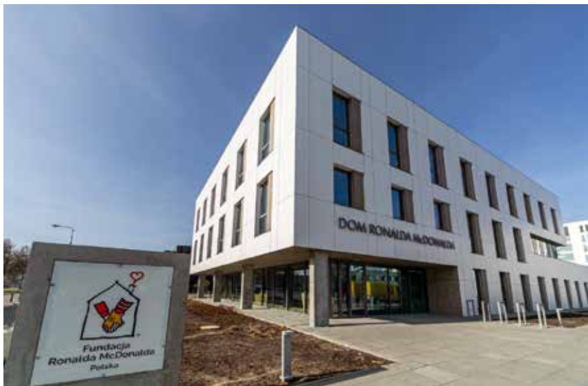
Fot. 4. Widok na wejście do domu Fundacji Ronald McDonald; źródło: fot. Michał Teperek, @FRM.org.pl
