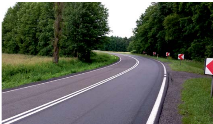
Fot. 3. Widok odcinka drogi krajowej nr 27 po zakończeniu prac (fot. Krzysztof Zalewa)
