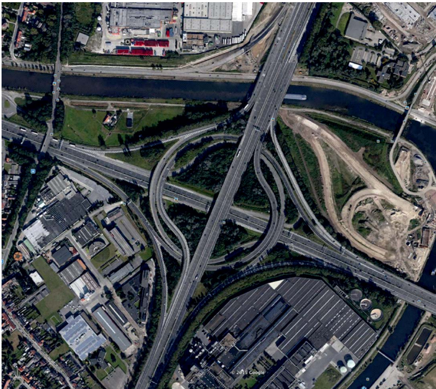
Fot. 1. Widok węzła drogowego w Belgii (źródło Google)
