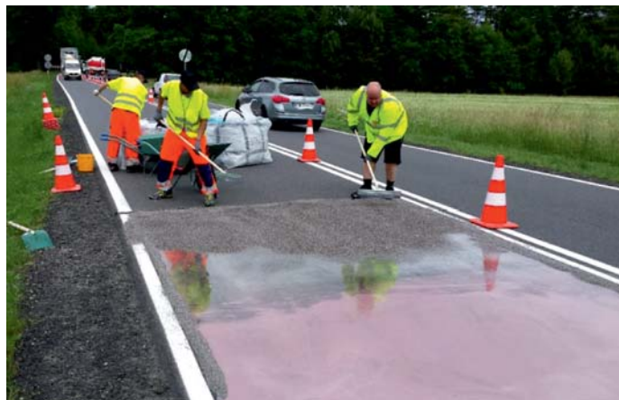
Fot. 2. Widok odcinka drogi krajowej nr 27 w trakcie wykonywania warstwy ścieralnej nopwt (fot. Krzysztof Zalewa)
