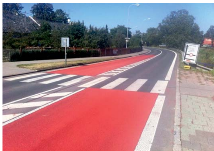
Fot. 4. Widok warstwy ścieralnej nopwt wykonanej przed przejściem dla pieszych (fot. Illya Torbica)
