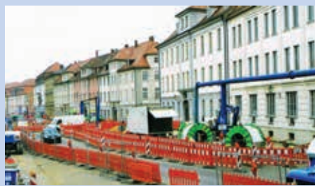
Ryc. 6. Renowacja rurociągu kanalizacyjnego w Ansbach
