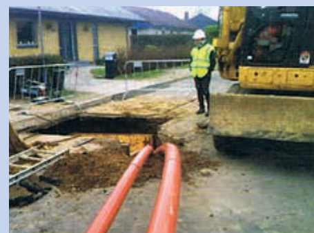
Ryc. 11. Instalacja dwóch rurociągów polietylenowych za pomocą technologii Pipe Bursting
