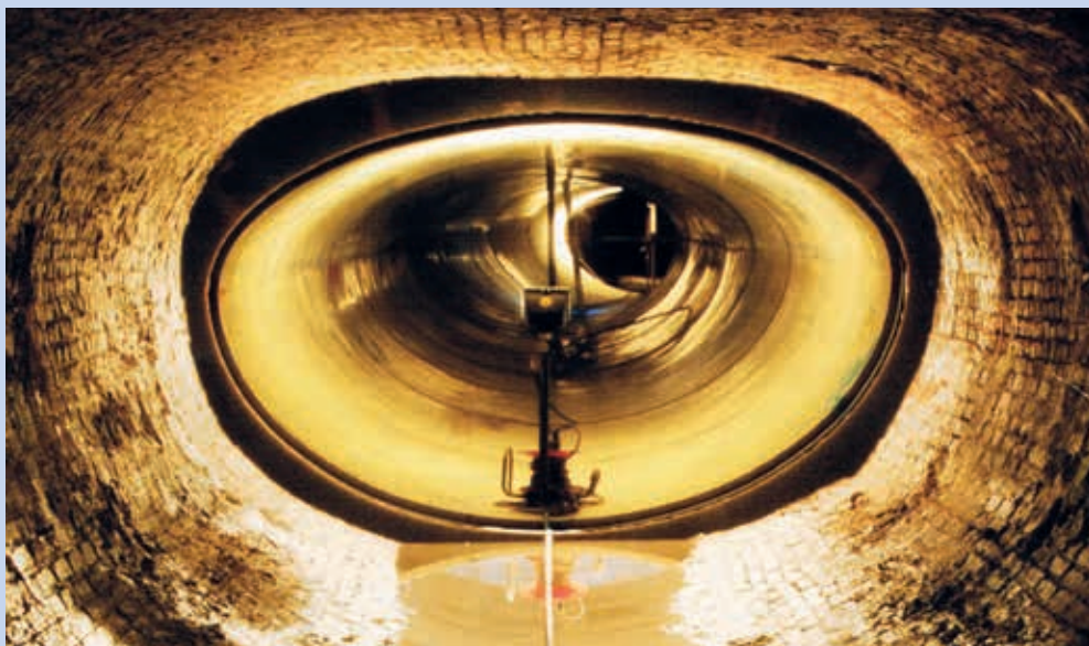
Ryc. 9. Rurociąg po renowacji rurami GRP w Leuven
