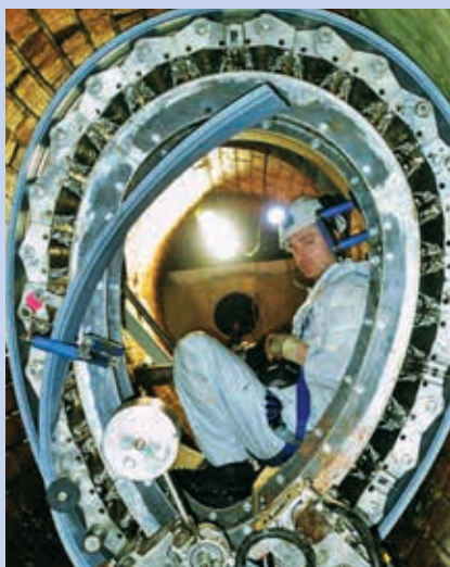
Ryc. 7. Urządzenie łączące profile SPR w trakcie pracy
