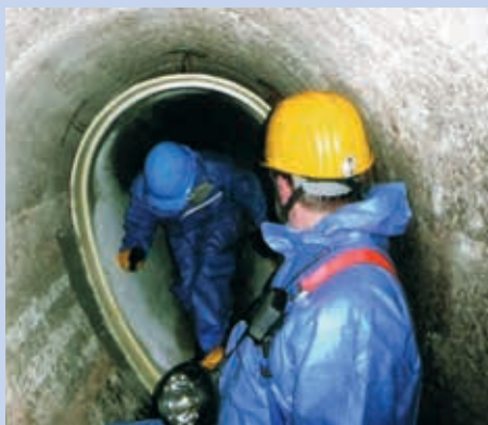
Ryc. 5. Renowacja rurociągu w Chociebużu
