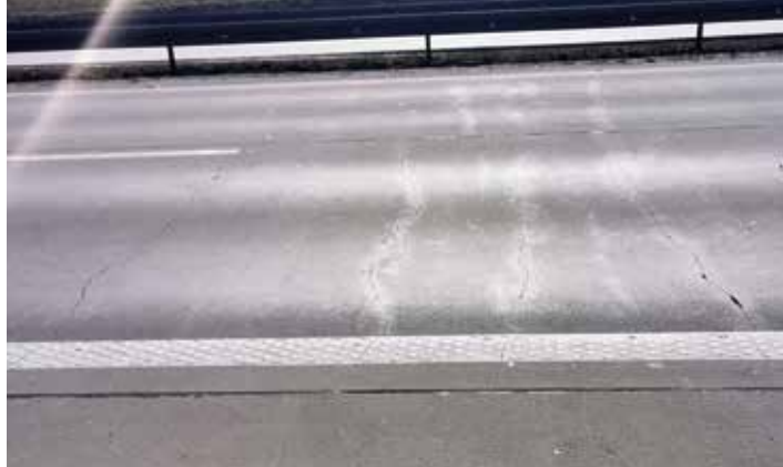
Fot. 2. Widok poprzecznych spękań włosowatych w odstępach kilkudziesięciu centymetrów nawierzchni wykonanej ze zbrojonej płyty betonowej bez szczelin poprzecznych. Źródło: [9]
