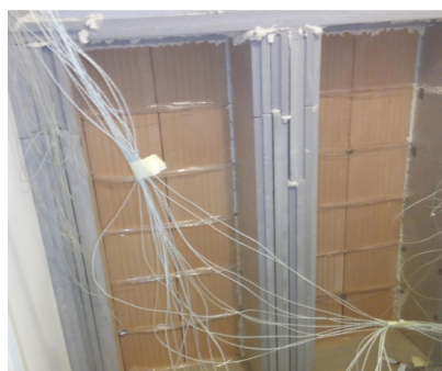
Rys. 2. Widok ścian od strony wewnętrznej
