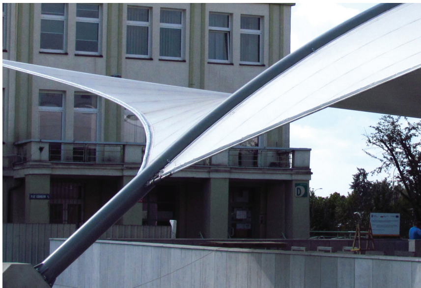
Rys. 8. Zamocowanie membrany
