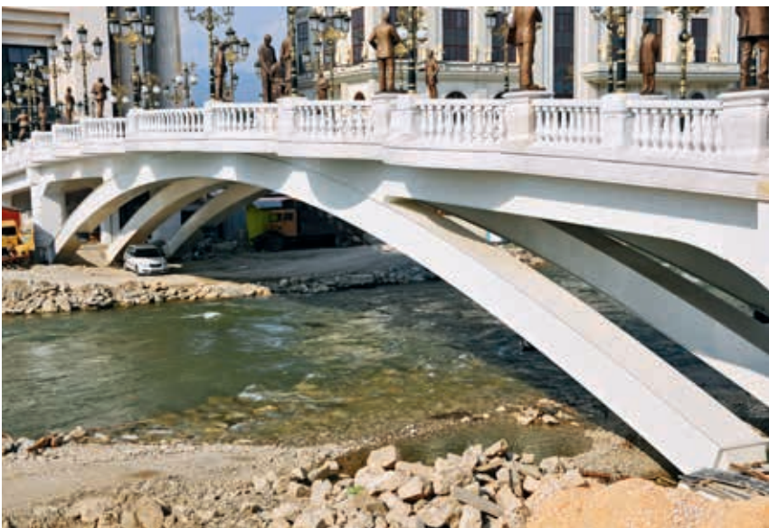
Ryc. 26. Żelbetowy, łukowo-belkowy most (drugi) dla pieszych przez Wardar w Skopje
