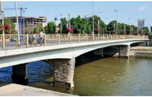
Ryc. 31. Betonowy sprężony most belkowy przez Wardar w Skopje
