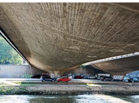
Ryc. 28. Betonowy, sprężony most powłokowy przez Wardar w Skopje
