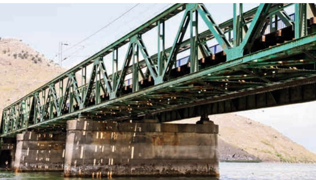
Ryc. 9. Stalowy most kolejowy przez Jezioro Szkoderskie, na trasie Sutomore – Podgorica
