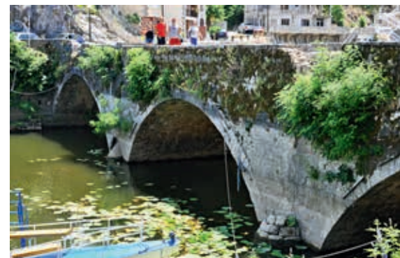
Ryc. 5. Kamienisty most łukowy w Virpazar nad Jeziorem Szkoderskim
