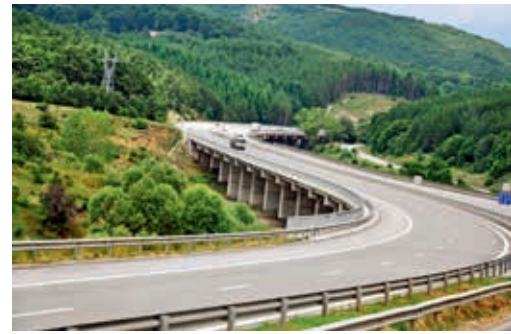
Ryc. 33. Betonowy sprężony wiadukt autostradowy na trasie Sofia – Wraca
