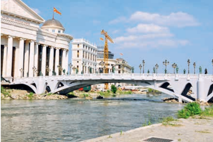
Ryc. 25. Żelbetowy, łukowo-belkowy most (pierwszy) dla pieszych przez Wardar w Skopje
