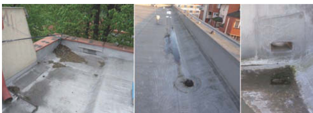
Rys. 4. Dodatkowe zabezpieczenie dachów w postaci otworów przelewowych, w przypadku zapchania się wpustów dachowych
