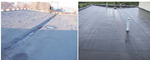
Rys. 2. Wewnętrzne koryta dachowe: a) drożne, b) niedrożny wpust dachowy, zapchany liśćmi z otaczających drzew
