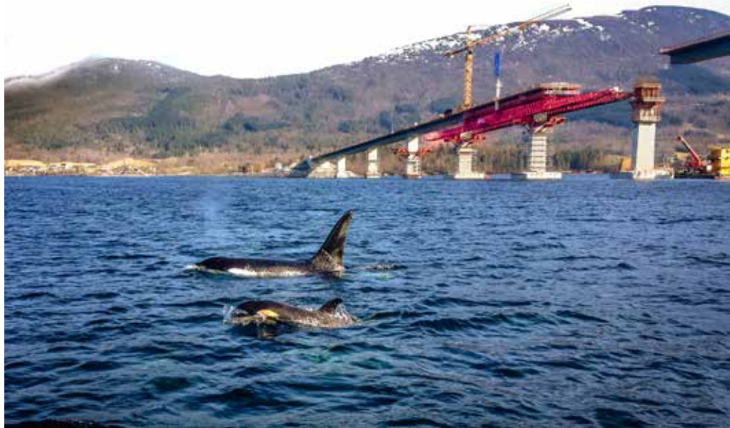
Most Tresfjord w Norwegii, na pierwszym planie stado orek, fot. PORR Polska Infrastructure SA
