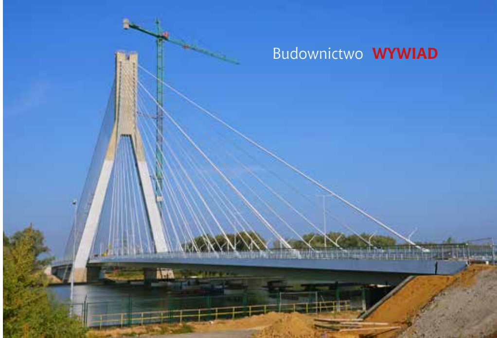
Most przez Wisłok w Rzeszowie, fot. PORR Polska Infrastruktura SA
