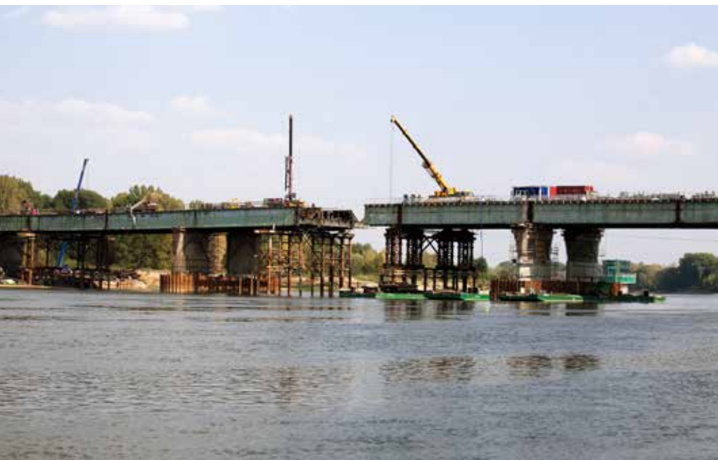
Most Łazienkowski w trakcie remontu, fot. PORR Polska Infrastructure SA
